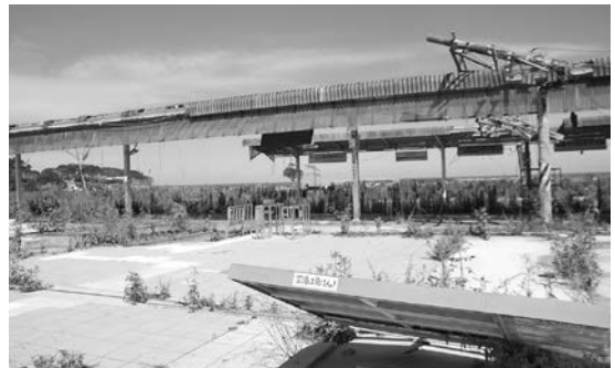
津波で破壊された富岡駅
